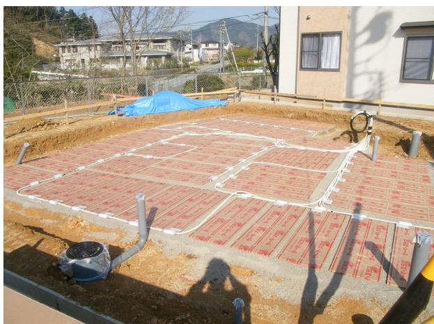
絶縁測定及び回路抵抗を測定し完了
