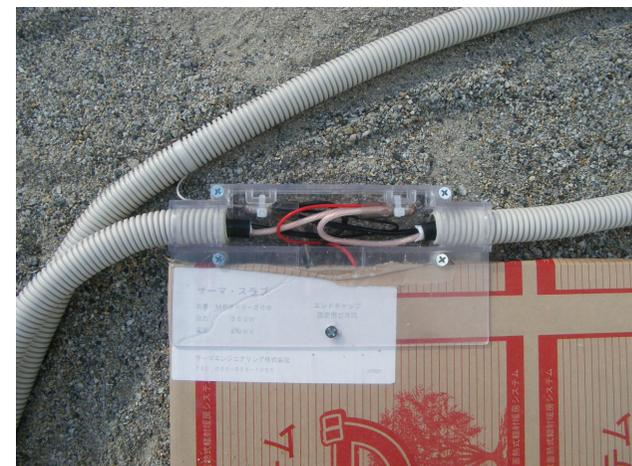
PF配管とCV線を接続結線
